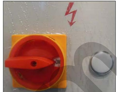
Figura 7 - Sezionatore generale dell'alimentazione elettrica.
